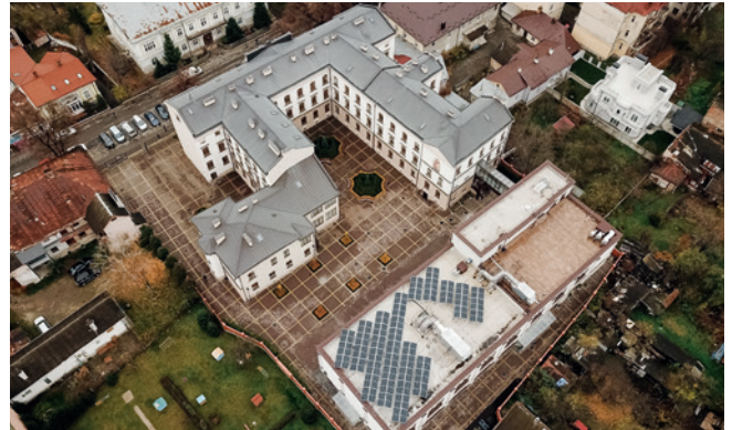
Haupt- und Erweiterungsgebäude der Schule mit Photovoltaikanlage, Foto: Projektpartner
